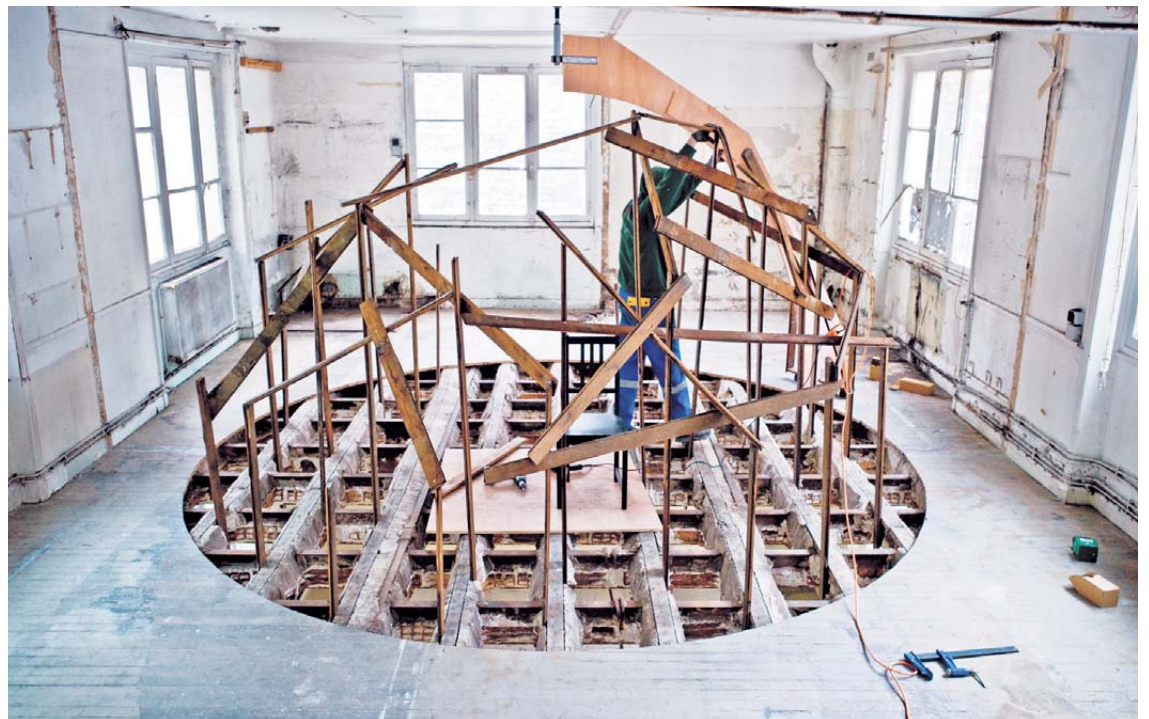
La sphère en bois de 4,40 mètres de diamètre imaginée par Sambre, encore en construction. Un clin d'œil à la boule à facettes et au passé du club.
